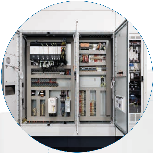
*UNIDADE DE EXAUSTÃO
